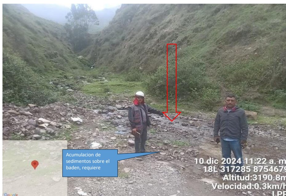
FIGURA N°03: EN LA TEMPORADA DE MAXIMAS AVENIDAS, LA QUEBRADA SHISHIN SE SEDIMENTA Y REALIZA DESVIO DE AGUAS OCACIONANDO, DETERIORO DE LA CARRETERA.
